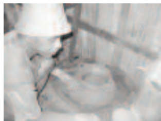
5. Maka vilany iray, ary arafitra manodidina azy ny fotaka efa voavolavola. Tsara raha 15 sm ny haavony aloha, asiana endrika toy ny varavarana ka ny tananà 2 no atao refiny.
